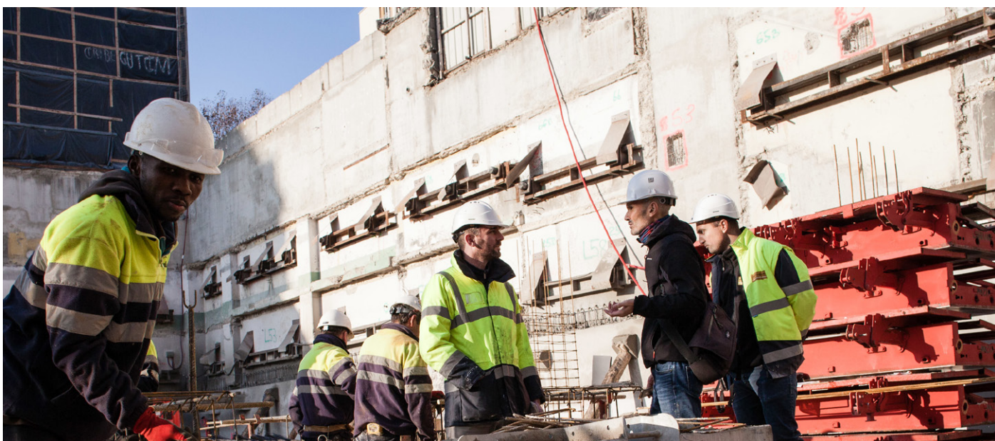
Contrôle sur un chantier de construction dans les Hauts-de-Seine
